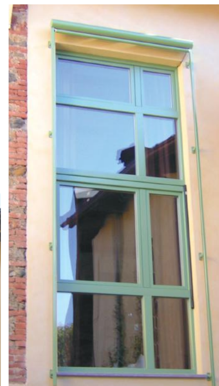
I profili in alluminio possono essere verniciati dello stesso colore dei serramenti, per mantenere l'armonia dell'architettura.
